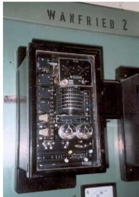
Bild 4: Distanzschutz RD10, EAW, UW Katharinenberg, 30-kV-Leitung Wanfried
