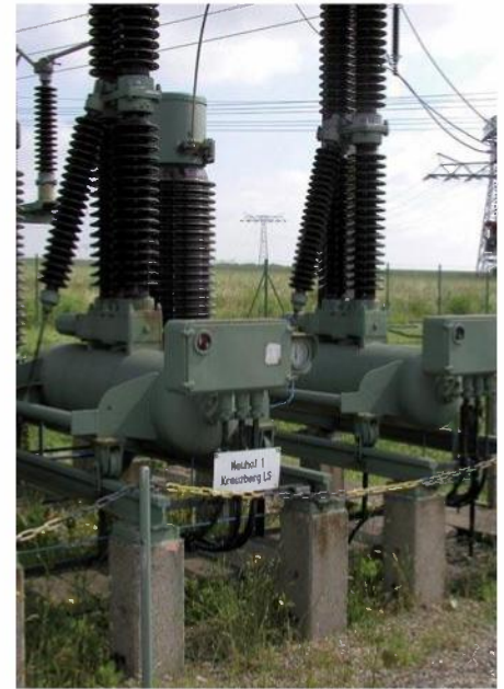
Bild 8: UW Wolframshausen, 110-kV-Schaltfeld Neuhof
