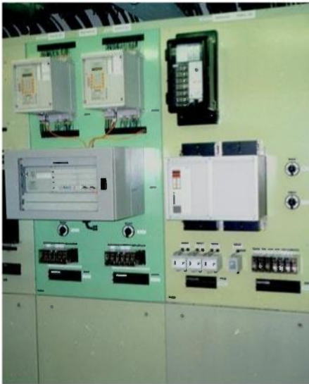
Bild 14: Schutz UW Remptendorf, Abg. Redwitz 253/254, Hauptschutz Distanzrelais PD551 mit AWE-Zusatz RM1-80, AEG und Reserveschutz Leitungsdiff. 7SD512 mit Signalübertragungsgerät SWT2000D, Siemens
