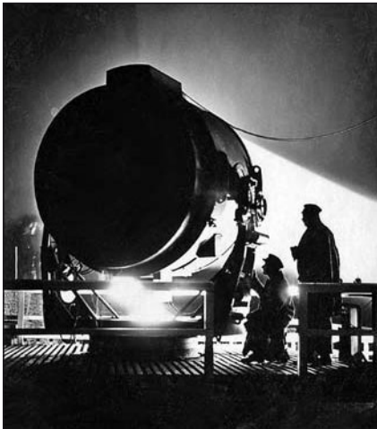
Beckscheinwerfer; Erfinder: Heinrich Beck, zusammen mit seinem Assistenten, Erich Koch, 1912 auf dem Dach des Physikalisch-technischen Laboratorium Meiningen beim Testen des ersten Scheinwerfer-Versuchsmodells. Bild: T. Beck
