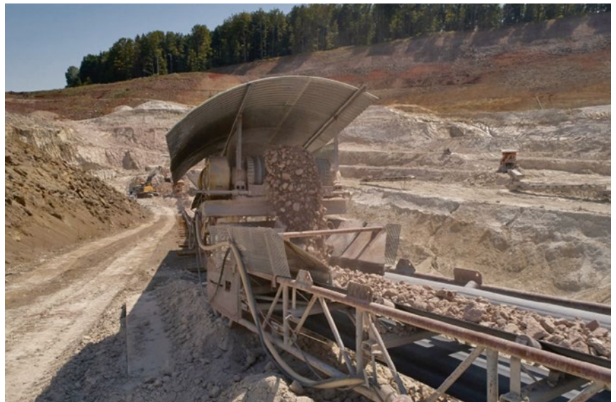
Bild 5 Das Gut wird zunächst mit fahrbaren Brechern zerkleinert und dann mittels Förderbändern transportiert. Hier findet auch die erste automatische Probenahme zur Kontrolle der Qualität statt. (© Frey)
