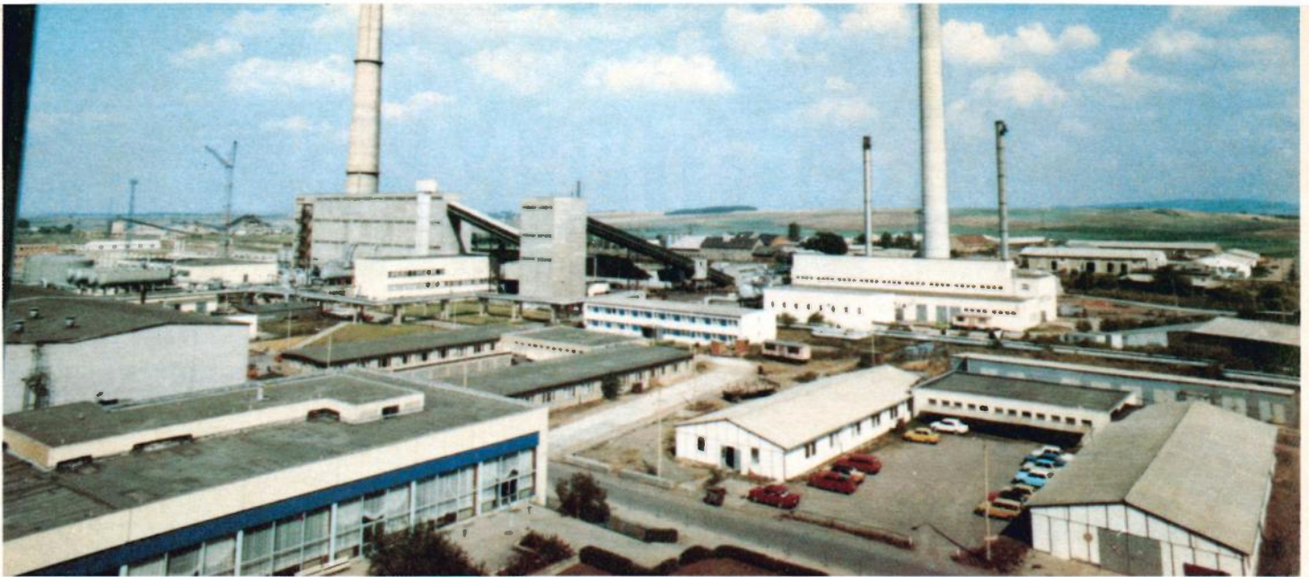
Betriebsgelände des Energiekombinats Erfurt mit Blick auf die Heizwerke Ost I und IV. Verfeuert wird Rohbraunkohle...
