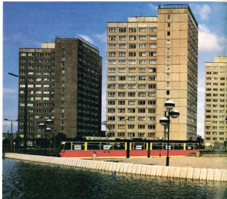
An das Fernwärmenetz angeschlossen: das Neubauviertel Rieth.
